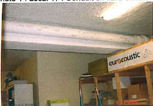
Photo 1 : Local 17 : Conduit en fibre ciment :
